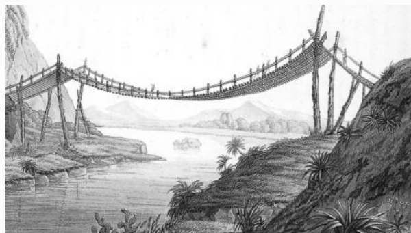
Puente en Penipe
