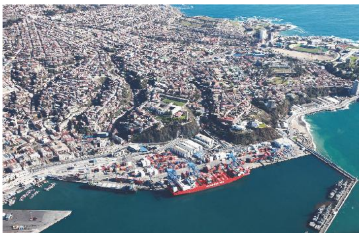
Terminal Pacífico Sur en Valparaíso (Chile)
