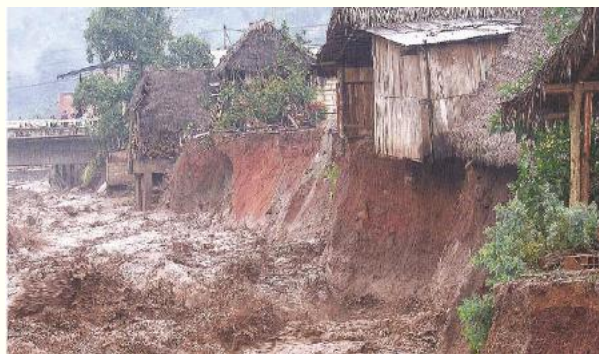
Viviendas en riesgo en la Costa ecuatoriana
